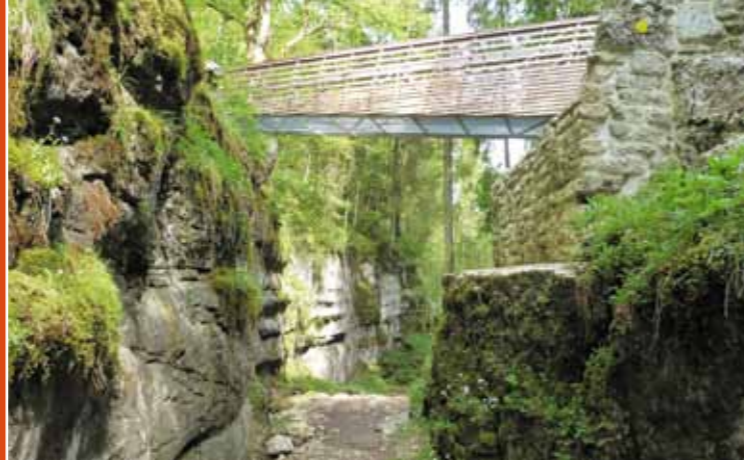
▲ Vestiges restaurés du Pont des Anabaptistes et nouvelle passerelle.
